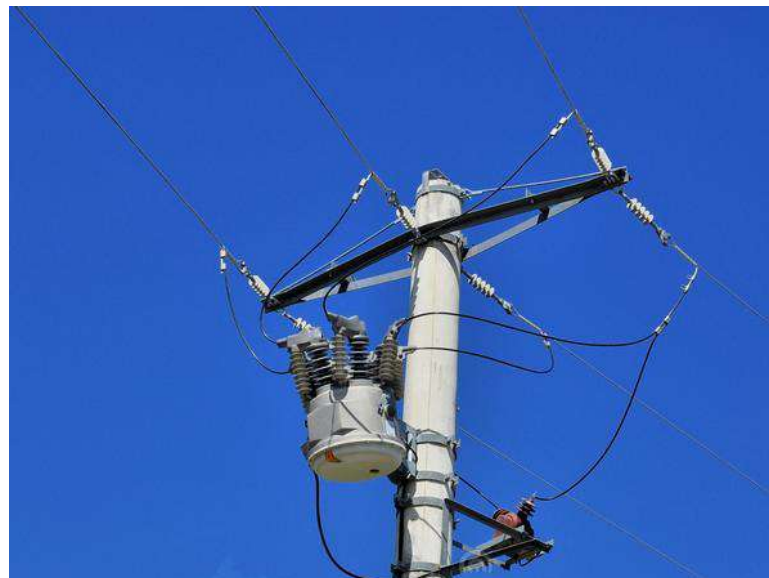
شکل (۳-۲۱) نمونه‌ای از استفاده از مقره کششی در نقاط با تغییر زاویه خط هوایی
