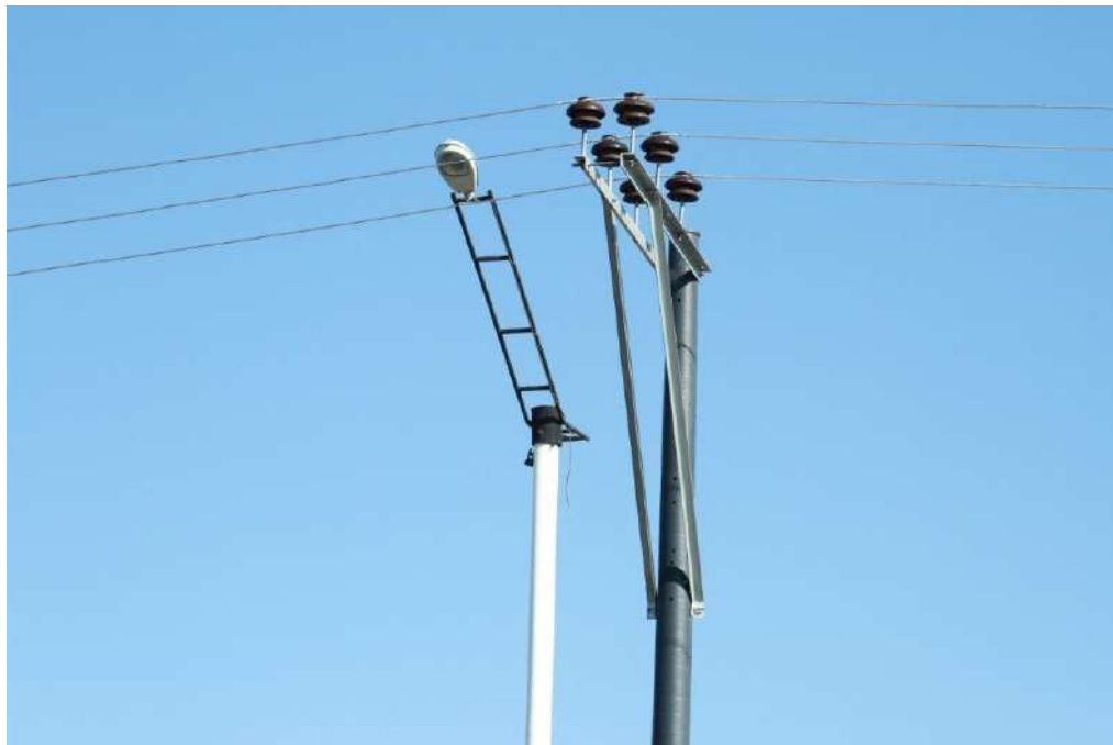
شکل (۳-۱۴) نمونه‌ای از استفاده از پایه‌های چدن نشکن
