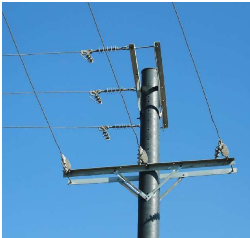
شکل (۱۱-۳) نمونه استفاده از پایه چدن نشکن در شبکه فشارمتوسط
